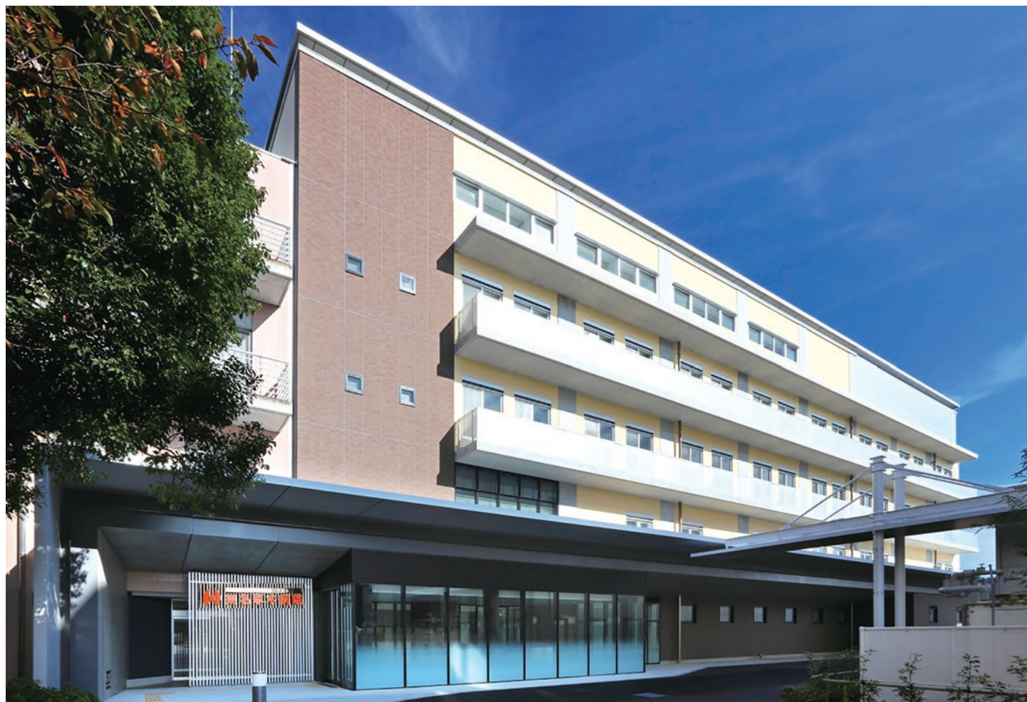
東名厚木病院・透析センター
