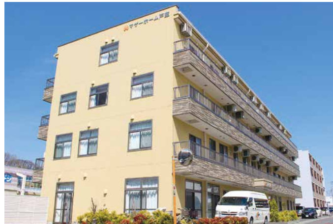
サービス付き高齢者向け住宅マザーホーム戸室 看護小規模多機能型居宅介護事業「いわしぐも」多機能型事務所「にじいろ」 訪問看護ステーション もみじ
