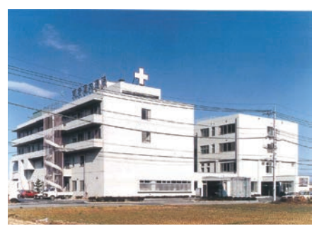
2号館増改築 202床
