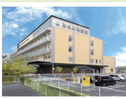
4号館増改築 277床
