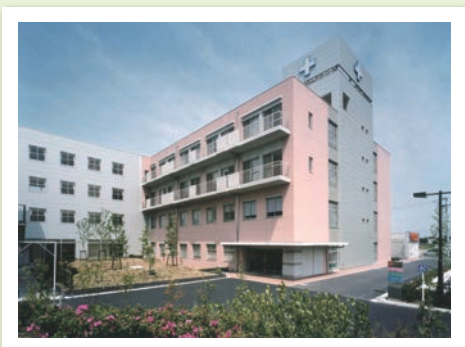
3号館増改築 199床
