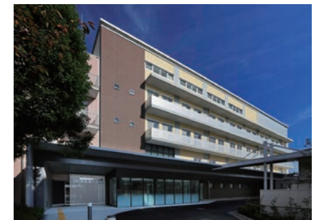
東名厚木病院 4 号館
