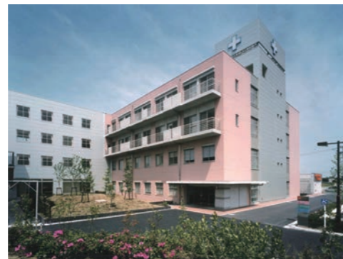
東名厚木病院 3 号館
