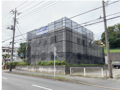
工事中のクリニック
